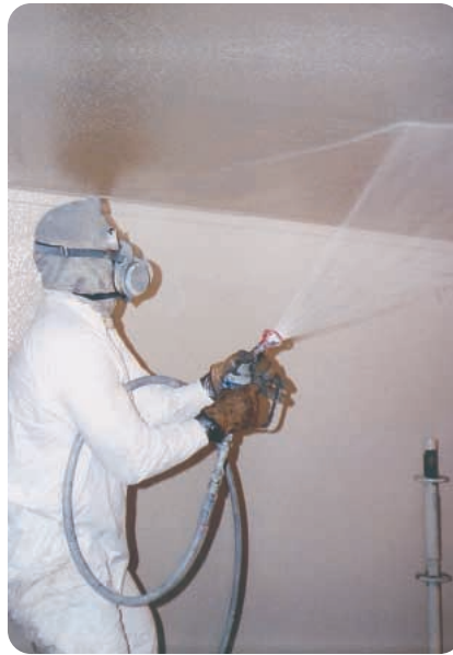
L'application par pulvérisation accélère la production, surtout sur les grands projets.
